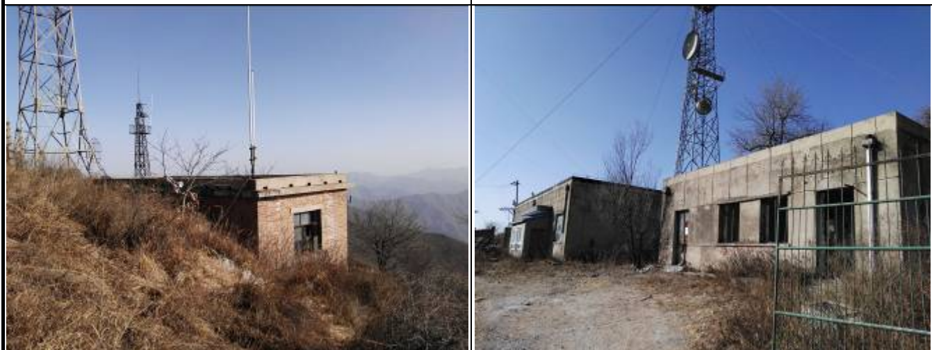
东南侧 22m 的废弃房屋 3
